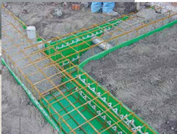
coffrages béton
